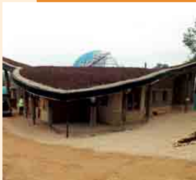
The Field Center“ ist zwar noch nicht ganz fertiggestellt, beeindruckt aber trotzdem sehr durch seine Architektur.
