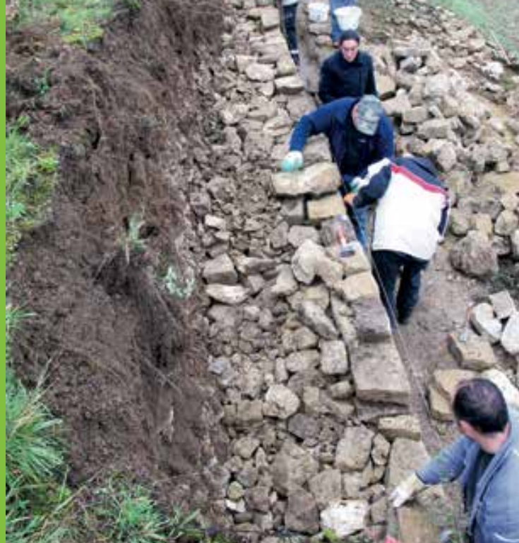
Das Reparieren der Stützmauern ist Facharbeit und wird vom Umweltministerium unterstützt.
